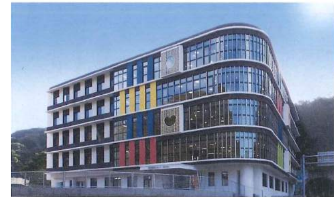
高台移転後の施設建物
